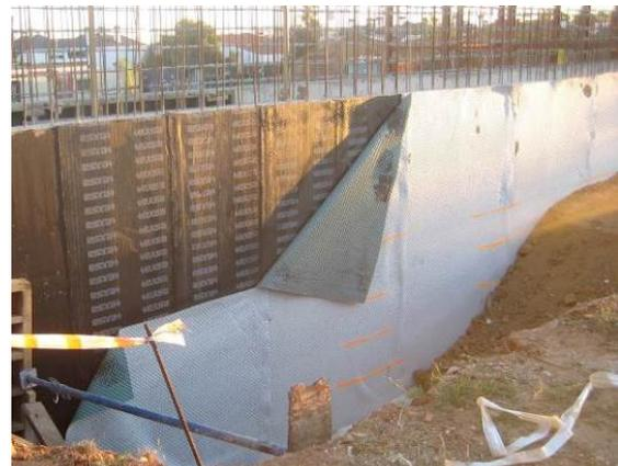
Fig. 6: Montaje lámina impermeabilizante + capa protectora
