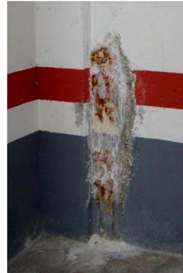
Fig. 4: Filtraciones a través de coqueras
