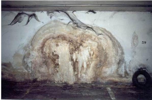
Fig. 3: Filtración a través de junta o fisuras
