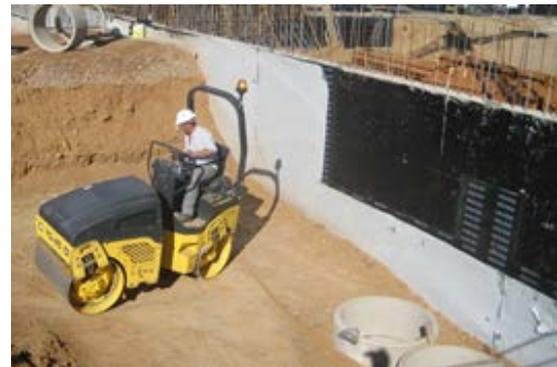
Fig. 2: Impermeabilización-capa drenante-compactación
