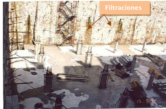
Fig. 1: Ejecución pantalla continua de H.A.
