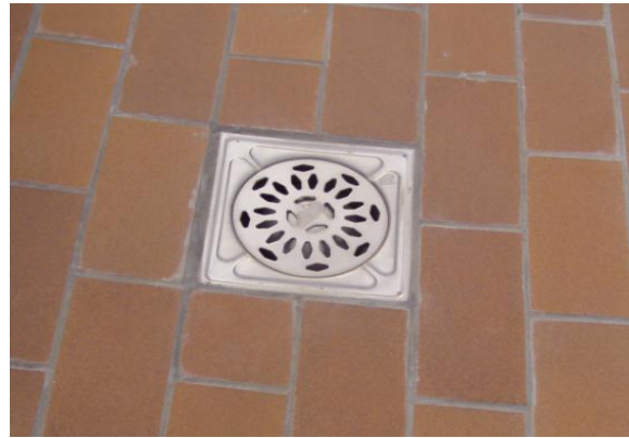
Fig. 1: Cazoleta en cubierta plana transitable
